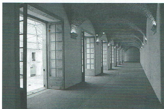
Claustro Superior do Convento do Beato com tecto tijolo-burro
